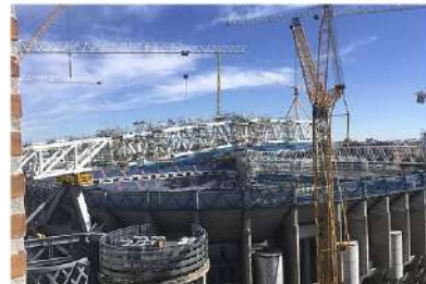
Obras en el Bernabéu. DANIEL AMADE
